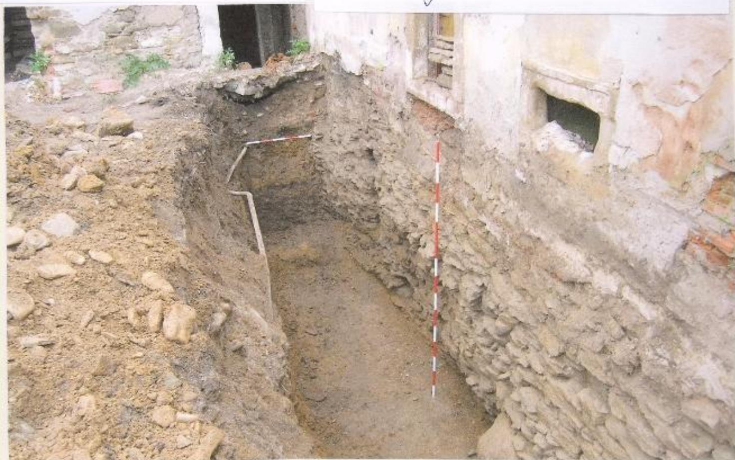
Geologický priekum v kaštieli do hĺbky 2,5 m.
