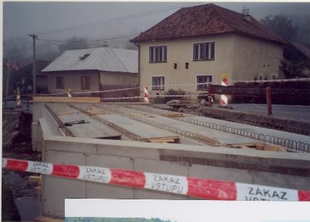
Betónová konštrukcia nového mestu. F-9
