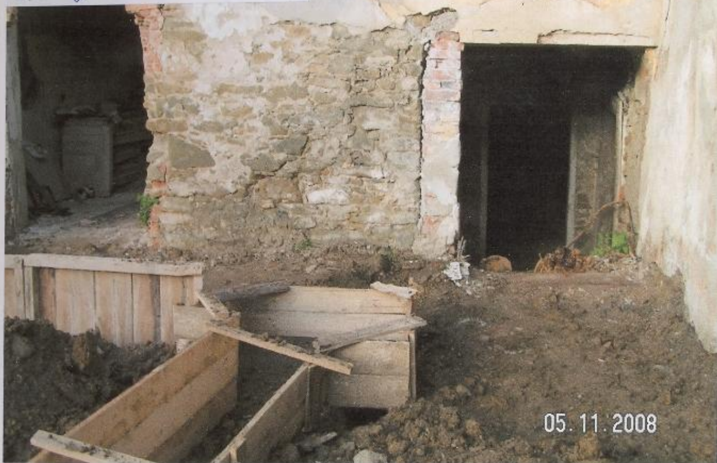
Príprava na betónovanie dchozy v kostieli
