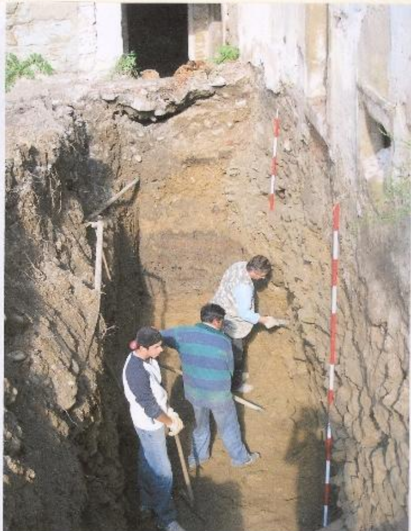
Geologický priekum v kaštieli do hĺbky 2,5 m.
