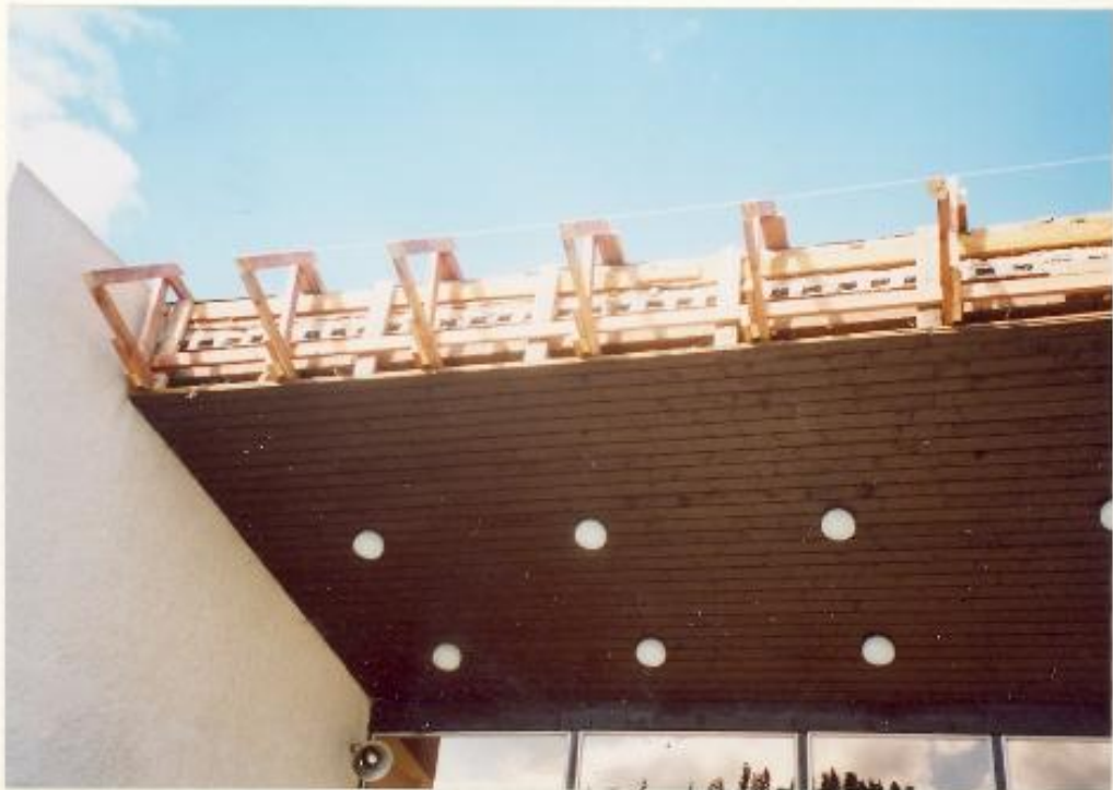
Dom smútku - rekonštrukcia strechy Foto č. 12
