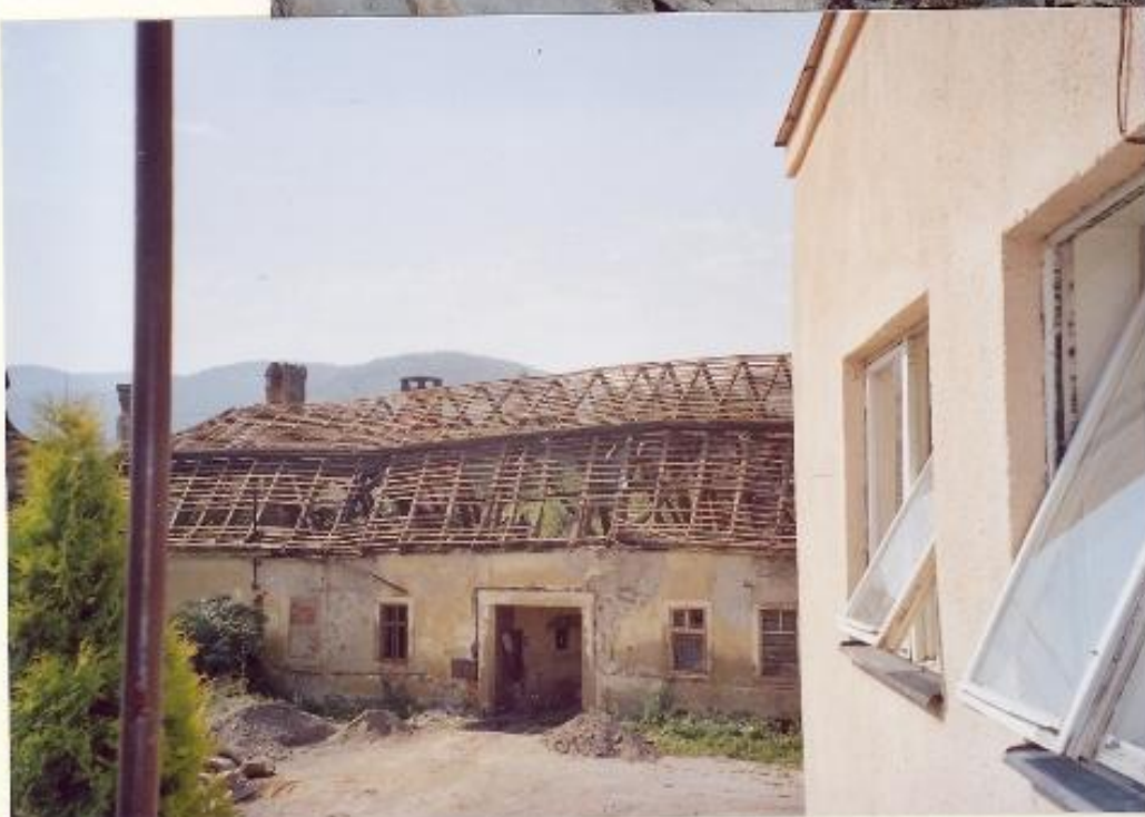
Odkrytá strecha kaštieľa v roku 2007 F8
