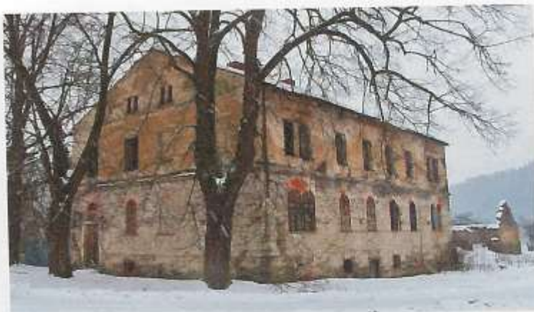
▲ Opustená budova závodnej správy
